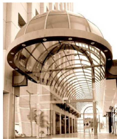
Иллюстрация 10. Типовое изогнутое остекление с использованием листа PALSUN. Застекленный навес перед главным входом в офисное здание и торговый комплекс. Холодногнутый прозрачный лист PALSUN толщиной 6 мм.
