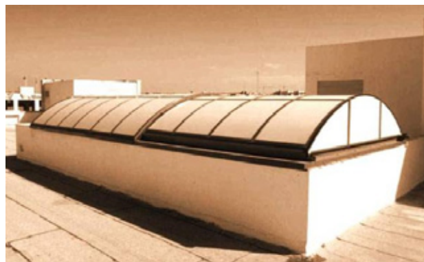
Иллюстрация 35. Подвижная застекленная крыша, использующая изогнутый матово-белый лист PALSUN.
